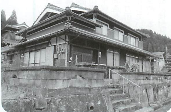
▲活用が期待される体験住宅
