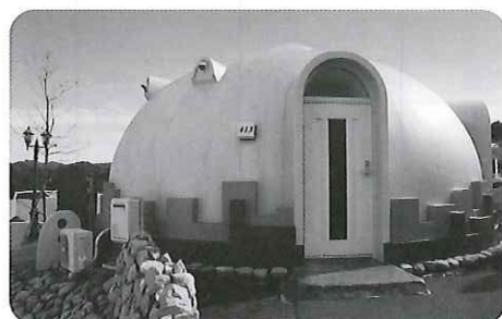
▲宿泊施設として設置されるドームハウス(写真は和歌山県白浜町の施設)
