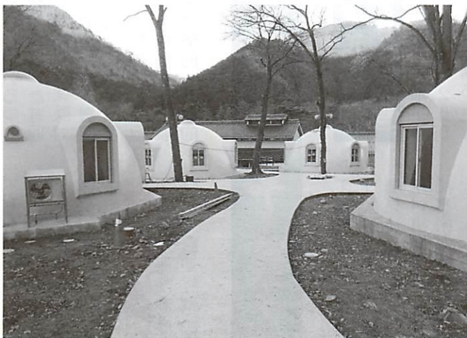
▲建設中のあさご芸術の森多々良木交流館ドームハウス
