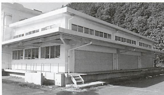
▲災害用物資が備蓄されている防災倉庫
