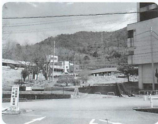
▲取り壊される旧和田山医療センター
