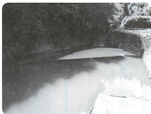
▲深谷川の沈砂池
