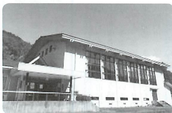
▲災害等でのガラス飛散防止対策が必要な避難場所等
