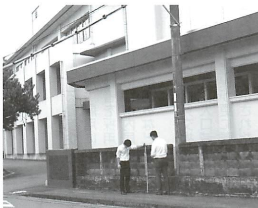
▲ブロック塀点検の様子
