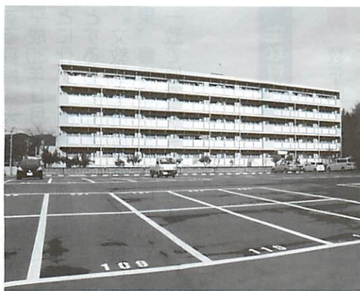
▲改修後の2号棟と駐車場
