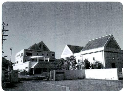
▲下水の浄化センター
