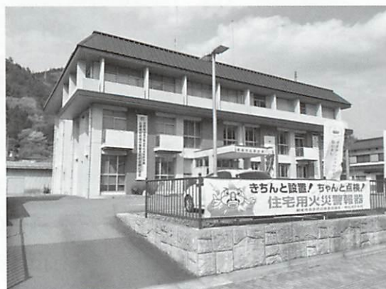
▲改修される生野庁舎
