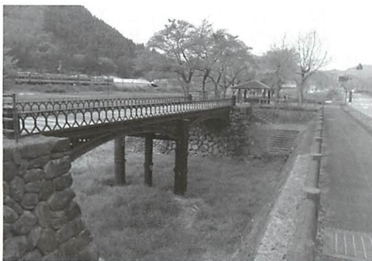
▲今後活用や整備が期待される 銀の馬車道 鉱石の道(羽瀧鉄橋)
