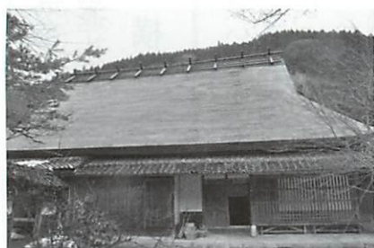
▲屋根の葺き替えが終了した 進藤家住宅(2022年2月)
