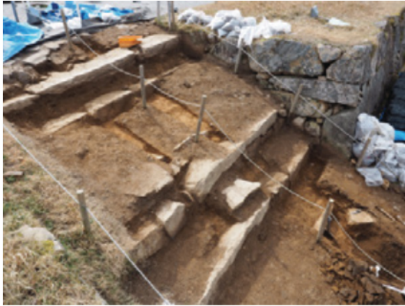
階段遺構の状況
