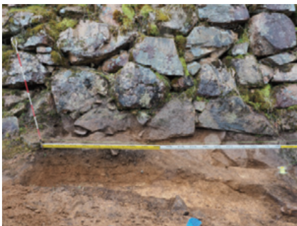
堀切肩の状況
