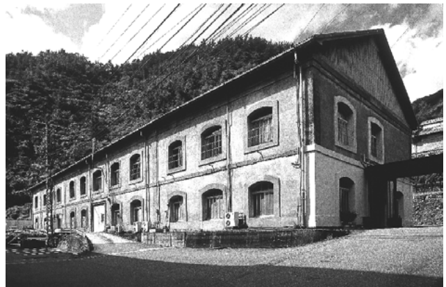
生野鉱山・旧混汞所(明治8年) 煉瓦造2階建
