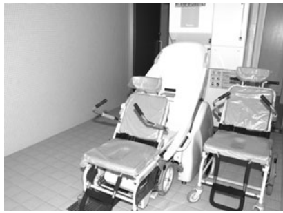
車いす対応機械浴槽
