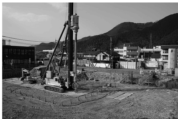
平成 28 年の完成へ向け整備が進む市役所新庁舎
