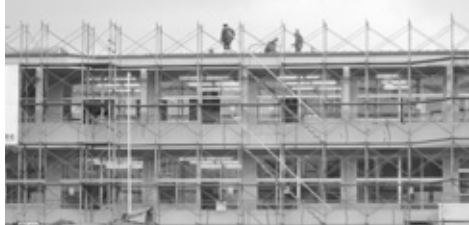
改造工事の全景
