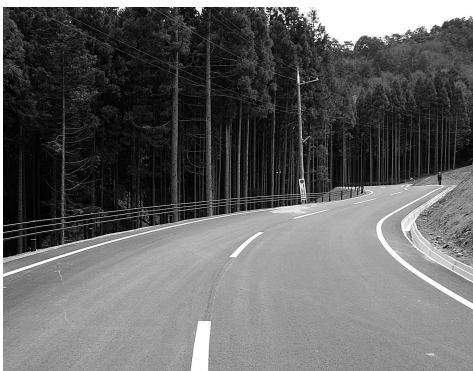
拡幅した道路
