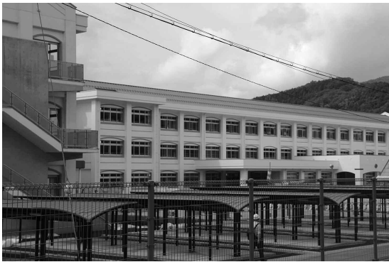
完成した新校舎
