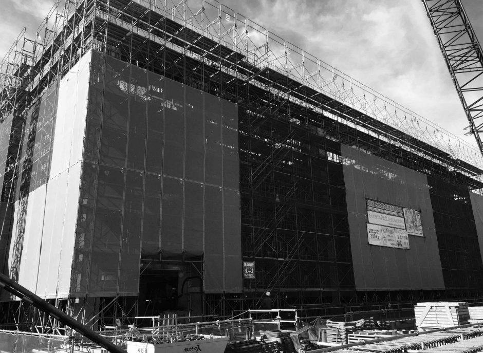
工事が進む新庁舎(11月5日撮影)
