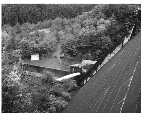
小水力発電所が整備される生野ダム
