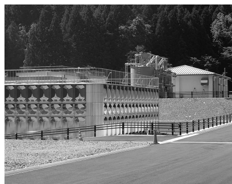
完成した与布土浄水場の施設
