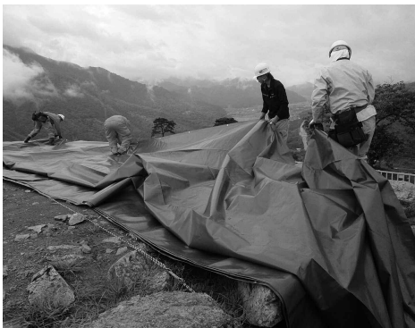
天守台での防水シート設置作業の様子(7月7日)
