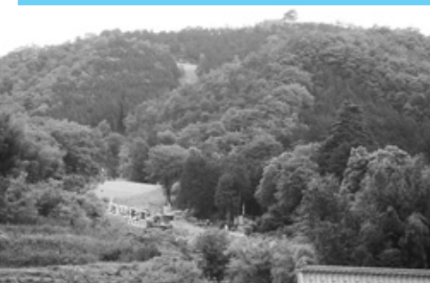
現在も復旧工事が続く竹田城山ノ下。工事は今年度で完了の予定。
