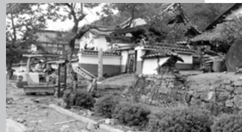
土砂被害にあった竹田寺町通りの寺院
