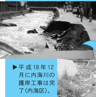
◀護岸が崩壊し、寸断された道路。集落が孤立した(内海区)。
