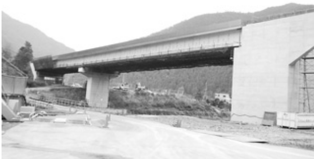
写真3 建屋川の橋梁工事(H 20. 10. 31 撮影)
