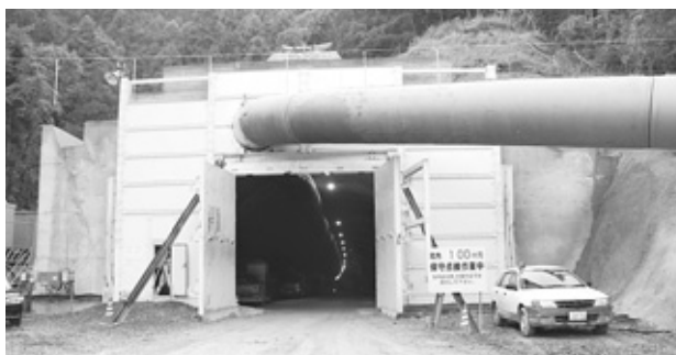
写真1 岡地区トンネル工事(H 20. 10. 30 撮影)
