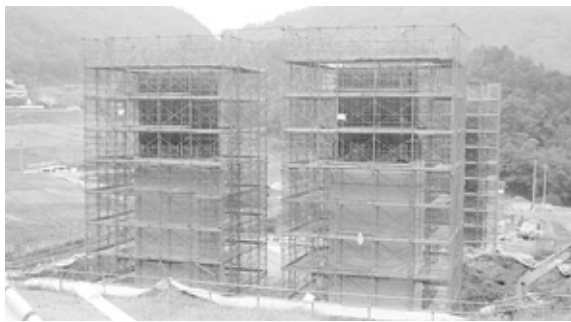
写真2 岡・芳賀野地区高架橋工事(H 20. 10. 31 撮影)
