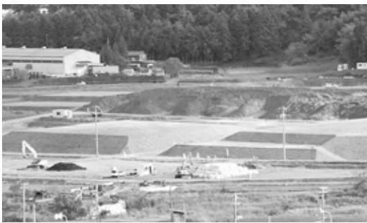
写真4 (仮称)八鹿IC設置工事(H 20. 11. 12日撮影)
