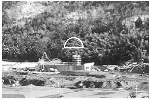
八鹿トンネル設置箇所(2月17日撮影)
