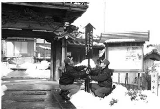
防火立看板を設置する市消防本部職員(浄願寺)
