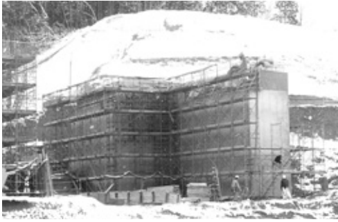
芳賀野高架橋工事(2月18日撮影)
