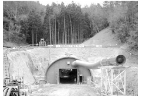
別所トンネル工事(2月13日撮影)
