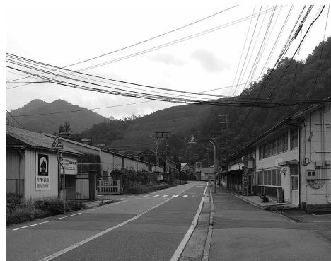
景観形成地区となった太盛(たせい)地区
