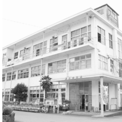
築後 50 年が経過した市役所本庁舎
