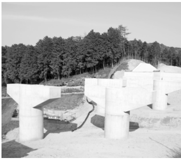
芳賀野高架橋
