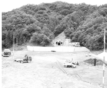
上谷トンネル
