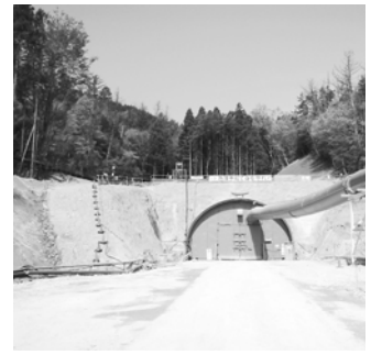
別所トンネル
