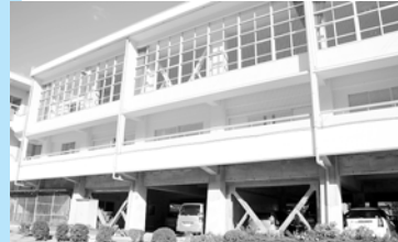
耐震補強ブレース(筋交い)を設置した枚田小学校体育館(小・中学校大規模改造・地震補強対策事業)
