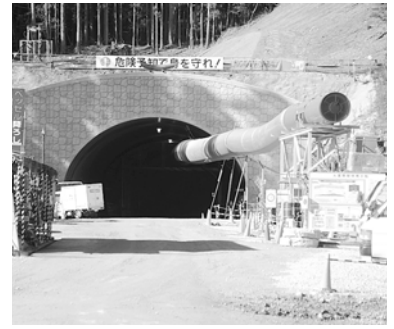
⑤別所トンネル
