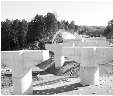
④芳賀野高架橋
