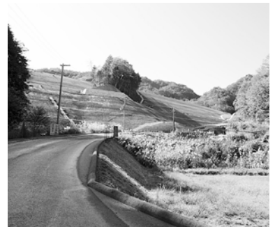
①上谷トンネル坑口付近の大規模盛土
