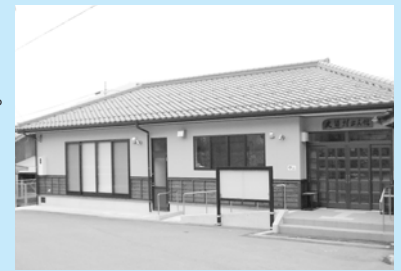
建て替えられた久留引区公民館
