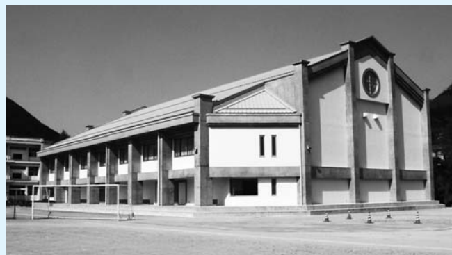
和田山中学校屋内運動場
