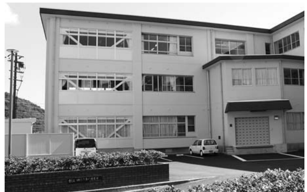
耐震化工事が完了した大蔵小学校
