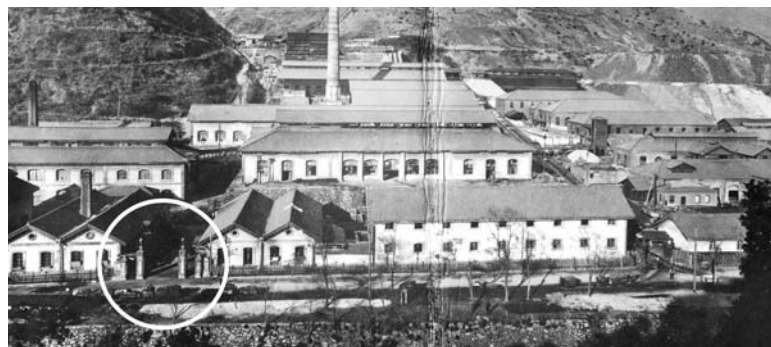
②明治中期頃の生野製鉄所(○印内が正門)
