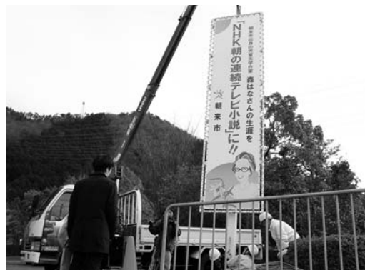
クレーンを使って看板が設置されました。
