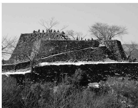
見学路を設けた本丸・天守台付近
