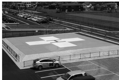
病院北側に設置されたヘリポート
