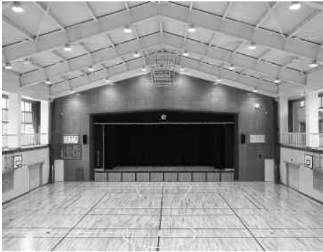
大蔵小学校体育館
