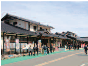
山城の郷改修工事が完成
