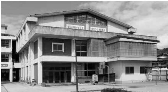
大規模改造に取り組む梁瀬小学校屋内運動場
