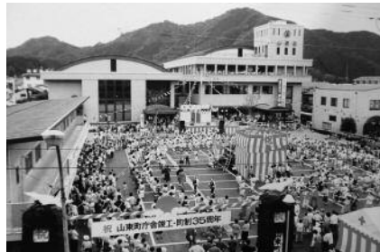
▲山東町役場庁舎完成(平成元年6月)
