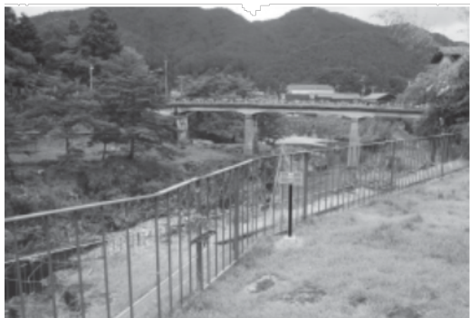
姫宮神社手前の姫宮橋(口銀谷) ※口銀谷銀山町ミュージアムセンター内に設置
