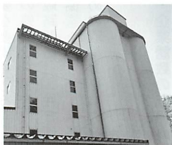
▲仁多米のカントリーエレベーター（奥出雲町）
