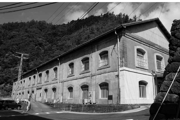
明治8年に完成した「旧混汞所」 現在も事務所として利用されています。
