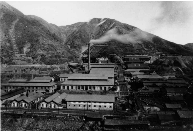
明治時代に完成した生野鉱山本部の全景
