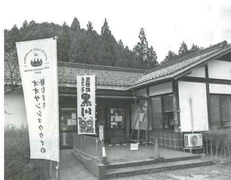
▲改修予定の黒川自然公園センター
