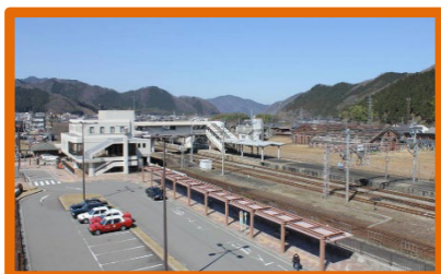
駅南北自由通路の整備 (JR 和田山駅)
