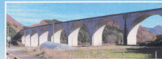
■ 虎臥城大橋(めがね橋)
