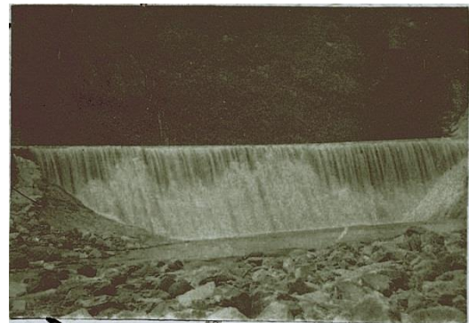
明治の鷹巣堰堤
