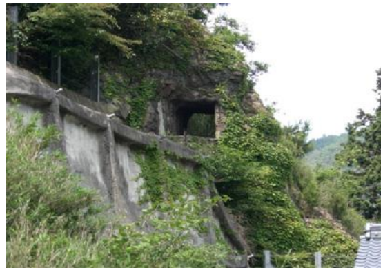
岩盤に残る旧送水路のトンネル跡
