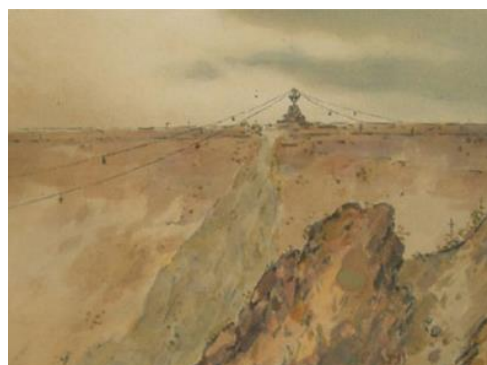
久宝ダム築堤中の索道と中継鉄塔
