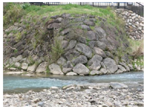
洪水防止のために設けられた亀石
